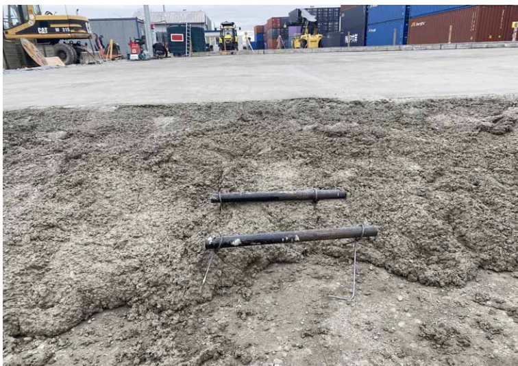
Rys. 6. Rozmieszczenie dybli w liniach dylatacji (fot. Autor)
