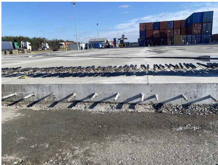
Rys. 7. Płyta betonowa dyblowana z rozstawem dylatacji co 7 m (fot. Autor)
