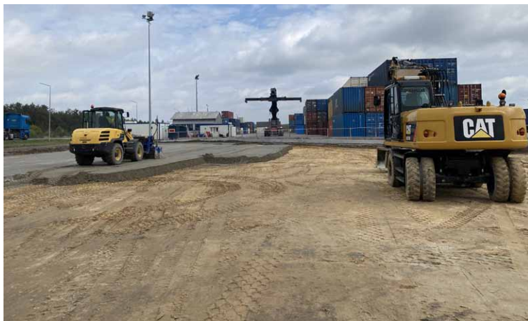
Rys. 4. Warstwa ulepszanego podłoża z mieszanki stabilizowanej cementem (fot. Autor)
