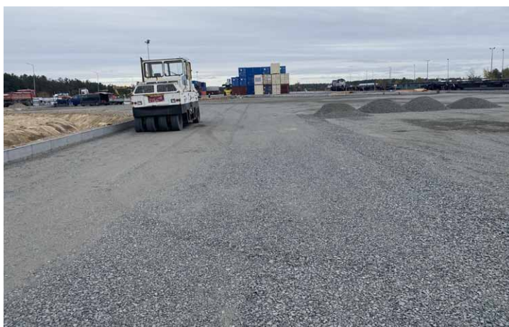
Rys. 5. Podbudowa z kruszywa łamanego stabilizowanego mechanicznie (fot. Autor)
