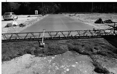
Fot. 2. Pneumatyczna listwa wibracyjna z przesuwem wciągarkowym Photo 2.
