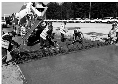
Fot. 1. Formowanie nawierzchni kompozytowej na podbudowie z kruszonego betonu Photo 1.
