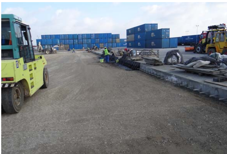
Fot. 1. Podbudowa zasadnicza z kruszywa łamanego stabilizowanego mechanicznie
