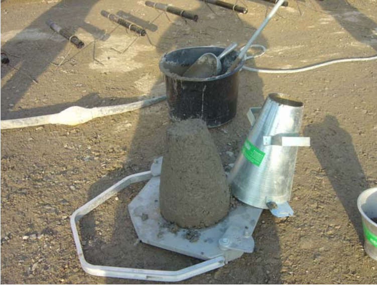
Fot. 2. Sprawdzenie konsystencji mieszanki betonowej na placu budowy
