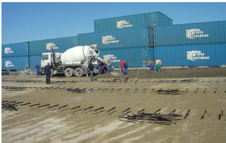
Fot. 3. Rozmieszczenie dybli w trakcie betonowania
