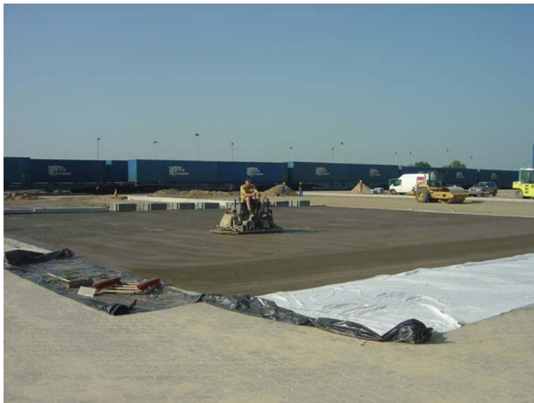
Fot. 4. Zacieranie, teksturowanie i pielęgnacja nawierzchni z betonu
