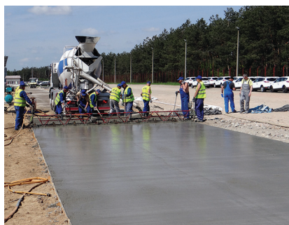
Fot. 2. Układanie nawierzchni drogowej z betonu przy użyciu pneumatycznej listwy wibracyjnej Fig. 2. Laying road pavement from concrete using a pneumatic vibrating stripe
