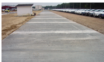
Fot. 3. Nawierzchnia betonowa jednej z dróg dojazdowych do placów składowych Fig. 3. Concrete pavement of one of the roads to storage yards
