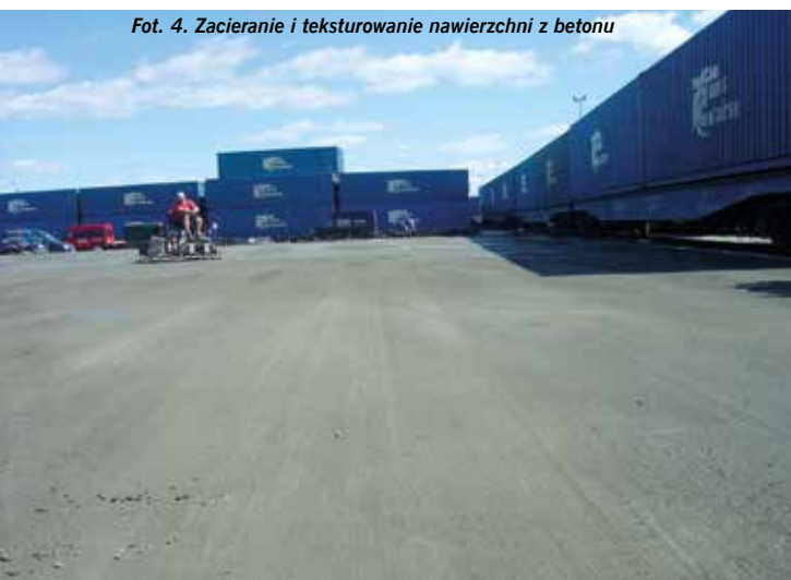
Fot. 4. Zacieranie i teksturowanie nawierzchni z betonu
