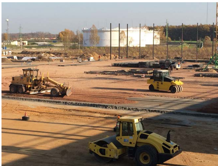
Fot. 1. Podbudowa zasadnicza z kruszywa łamanego stabilizowanego mechanicznie ułożona na piasku stabilizowanym cementem
