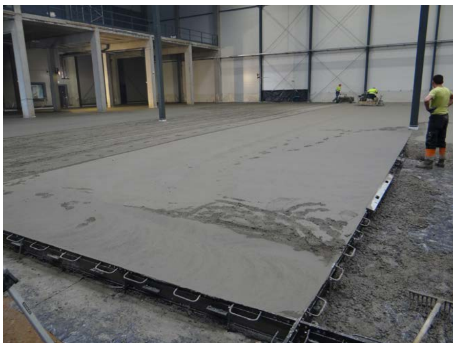
Fot. 2. Profile dylatacyjne z dyblami
