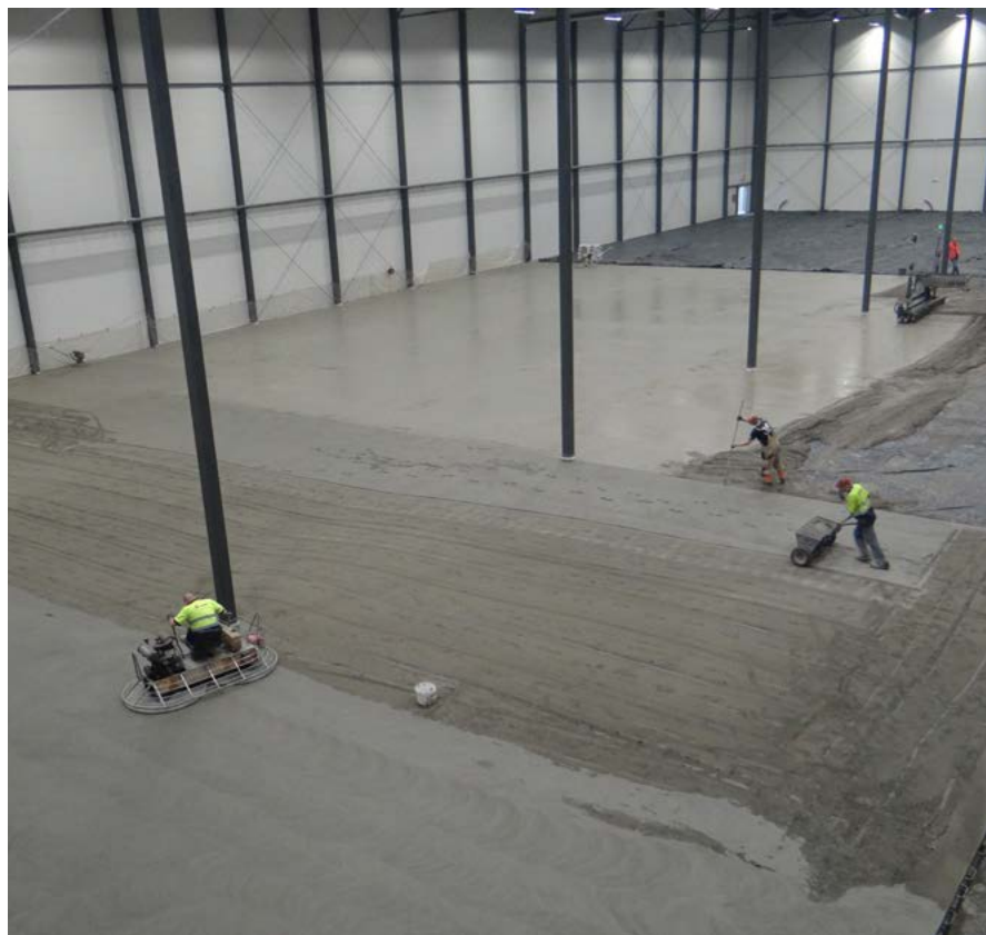
Fot. 4. Zacieranie i utwardzanie powierzchniowe posadzki
