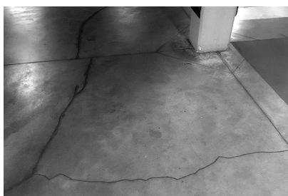
Fot. 2. Rysy naprawione w sposób trwale elastyczny Photo 2. Cracks repaired in permanently elastic way
